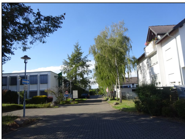
Abb. 6: Blick von Süden nach Norden auf das großzügig eingegrünte Betriebsgelände im östlichen Zentrum des Plangebiets.
